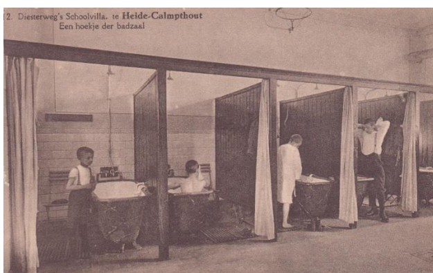
De bad-installatie in Diesterweg (1925)
